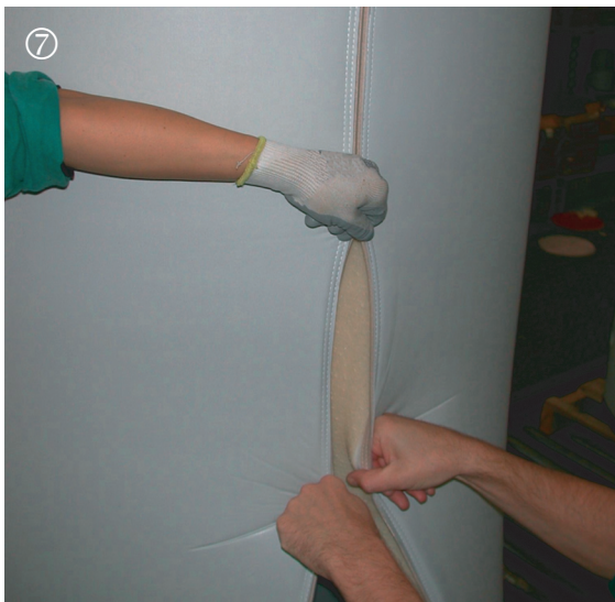
Images représentant le procédé de montage de l'isolation en mousse souple avec film PVC sur le réservoir d'accumulation. 11 |
