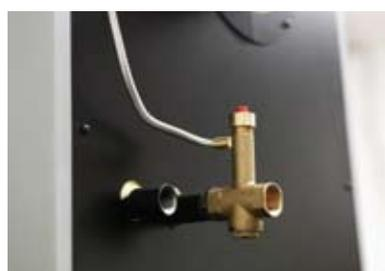
Montage typique de la vanne BVTS utilisée comme protection contre le bouillonnement de l'eau
