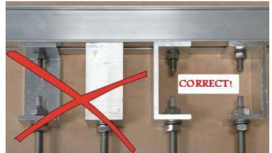
Fig.7: Présentation basique des différents éléments d'ancrage
